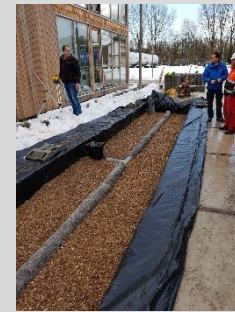
Boven: wadi om infiltratiecapaciteit te vergroten. Bron Midden: aanleg van daktuinen om meer water op te vangen. Bron Onder: aanbrengen van een schelpenlaag onder het wegdek om infiltratiecapaciteit te vergroten. Bron .
